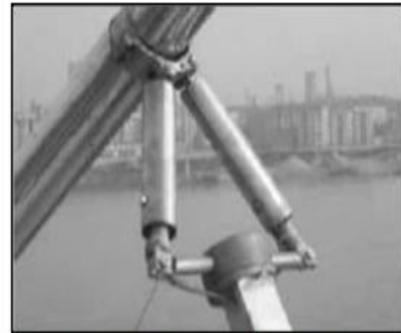
میراگرهای MR در پل Dongthng Lake
