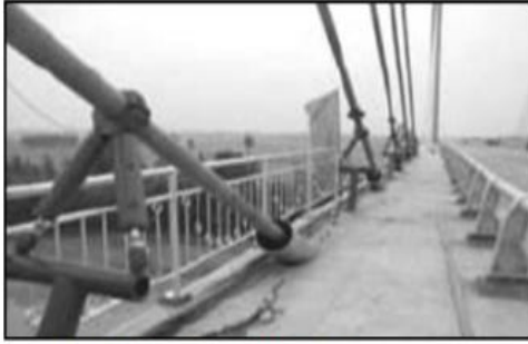
میراگرهای MR در پل Bin zhou
